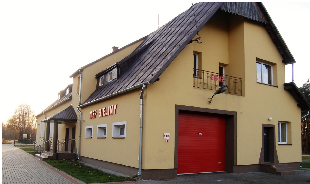
Budynek Ochotniczej Straży Pożarnej w Bielinach
